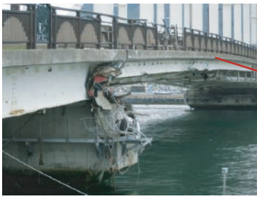
震災から数ヶ月後の万石浦橋。津波の爪痕が生々しく残る。
